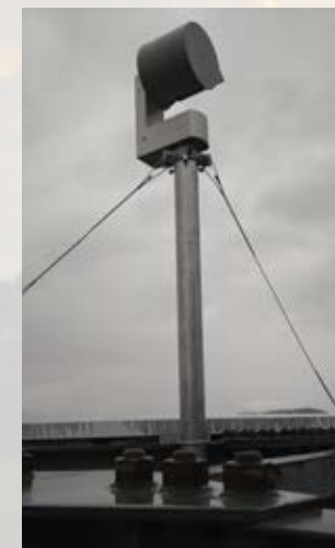
Beispiel für die einfache Montage der unterschiedlichen wetterfesten Kameras.
